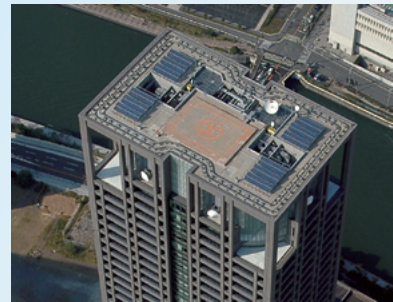
屋上・壁面の太陽光発電(関電ビル)
