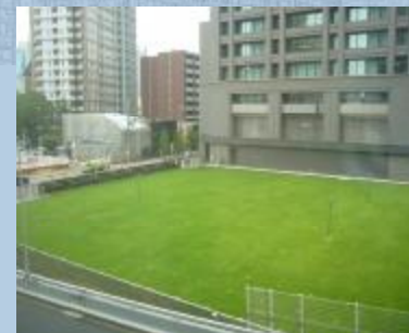
壁面・屋上緑化 ソーラパネルの設置
