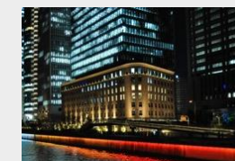
低層部のファサードをライトアップする例
